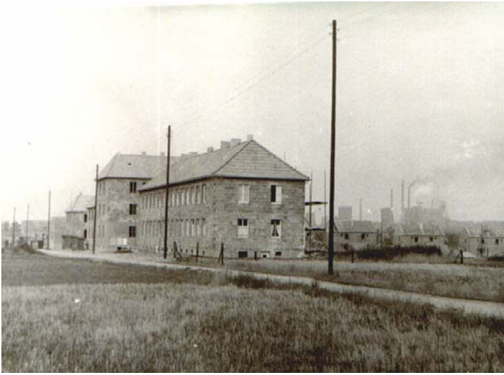
Fertigstellung der Häuser an der Musfeldstraße
