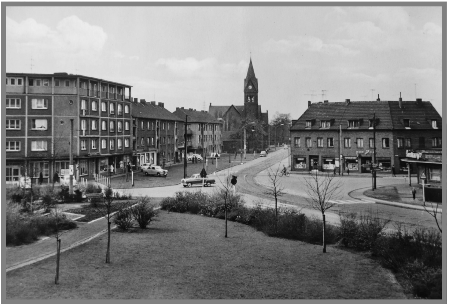
Buschhausen 1960, Stadtmitte mit Casinopark und Blick auf die ev. Lutherkirche
