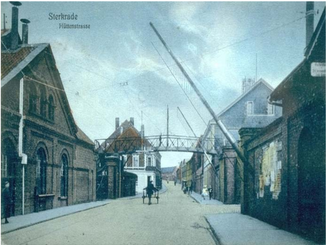
Um 1910 Die Bahnhofstraße teilte das Gelände der Gutehoffnungshütte
