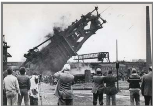
Sprengung des Hochofens A
