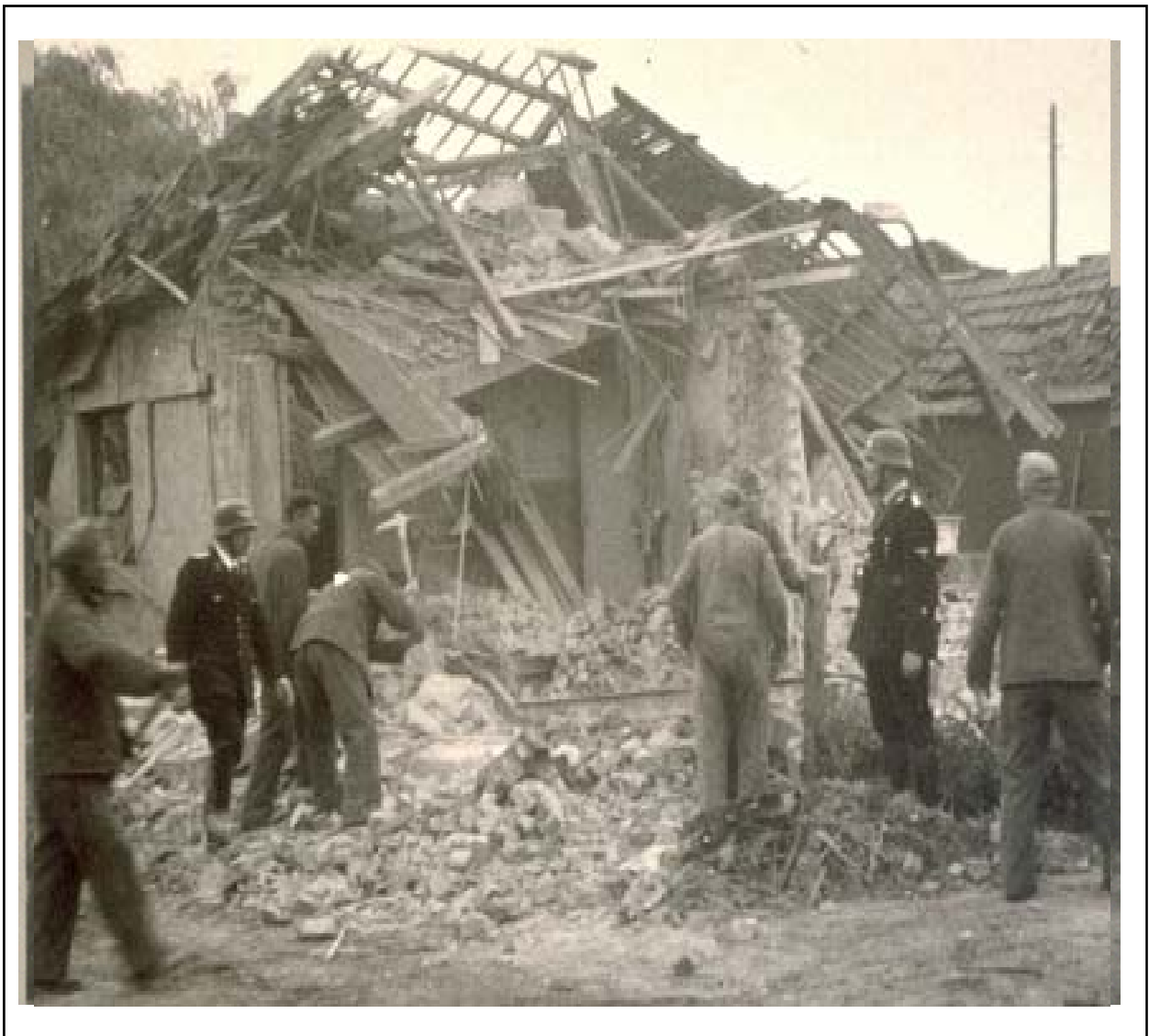
Neumühler- und untere Leuthenstraße nach einem Bombenangriff am 24 März 1945
