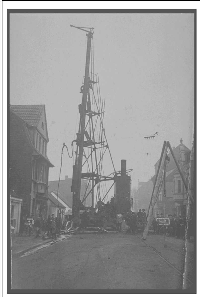
1926/1927, Rambär auf der Neumühler Straße zur Einbringung der Tiefkanalisation.
