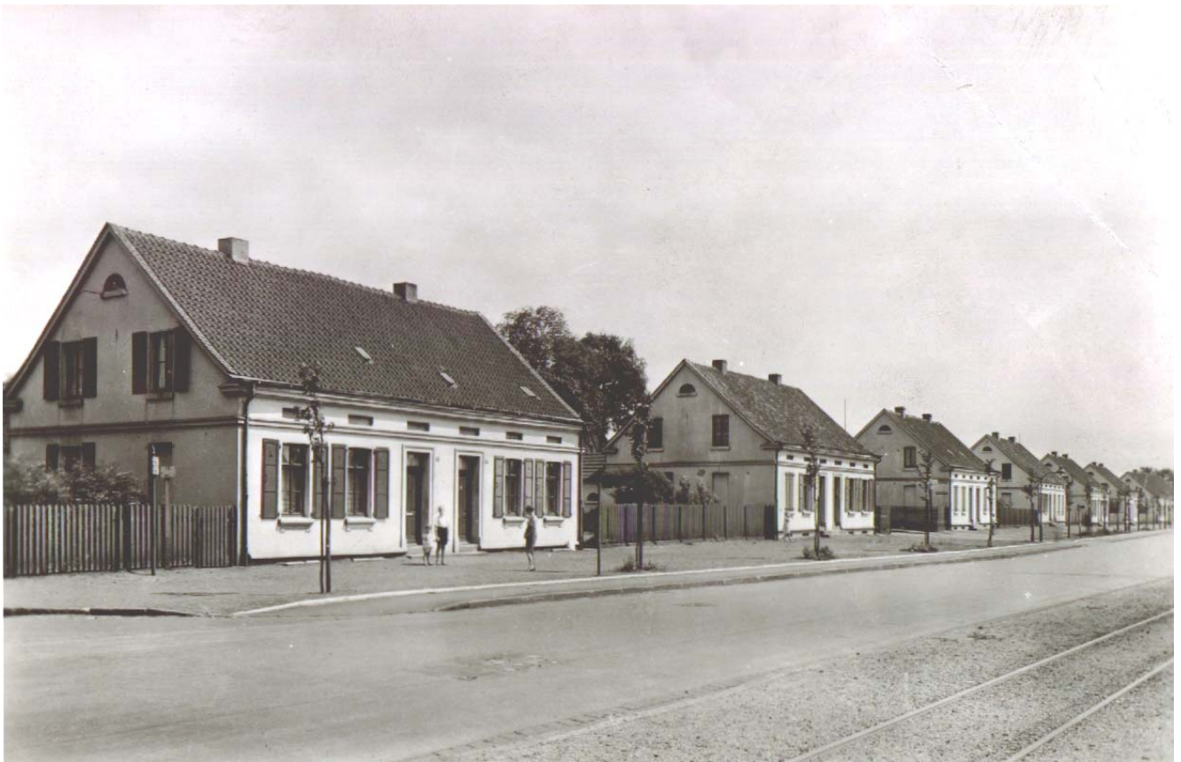
Meisterhäuser an der Sterkrader Straße (Abbruch der letzten Häuser 1964)
