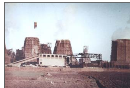
Kraftwerksanlage Zeche Sterkrade 1897 - 1996
