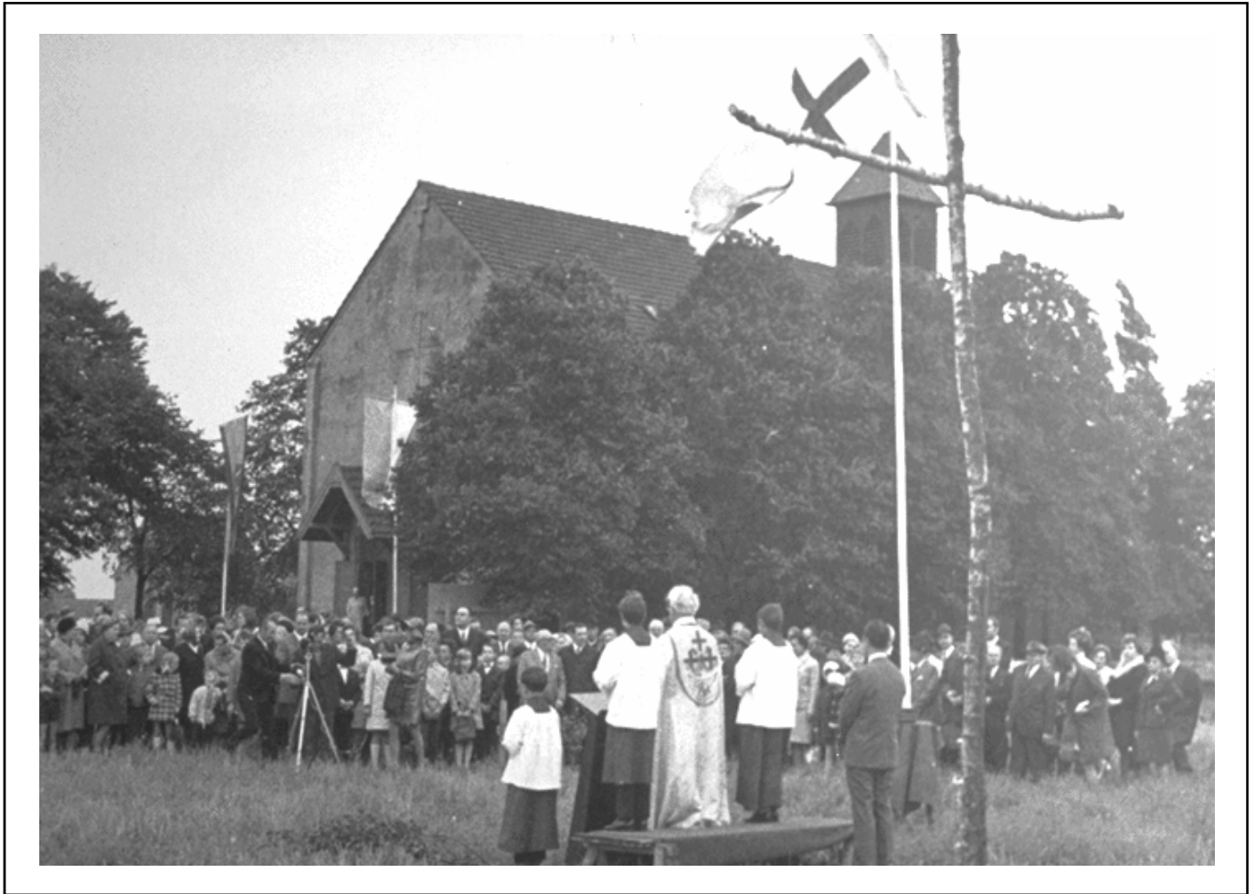
1971, erster Spatenstich zur heutigen St. Barbarakirche auf der Königshardt. Im Hintergrund die Notkirche St. Barbara, 1906 - 1973.
