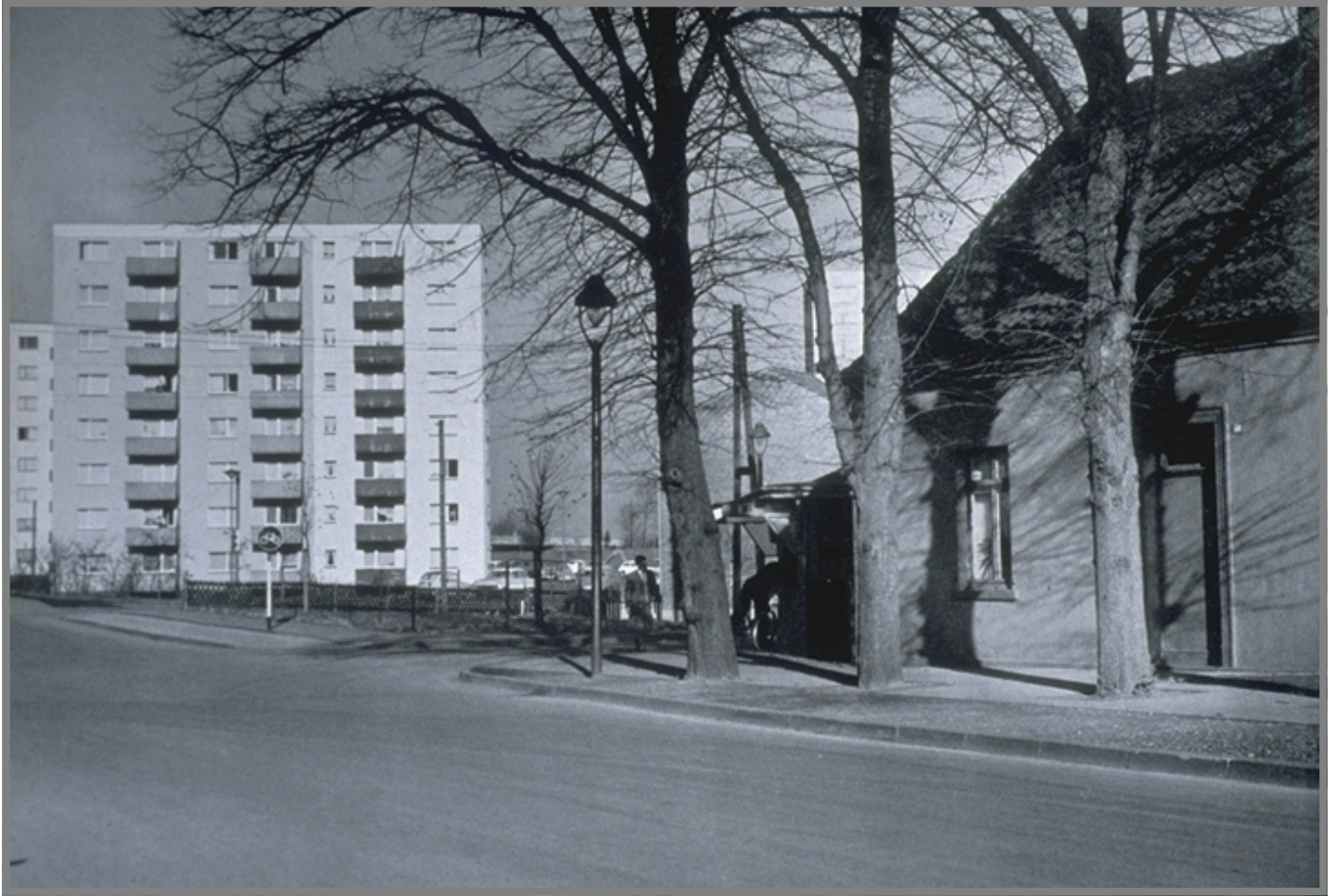
1959 Bezug der "3 Friesen". Achtstöckige Häuser mit 120 Wohneinheiten für Bergbauangehörige an der Friesenstraße in Buschhausen.
