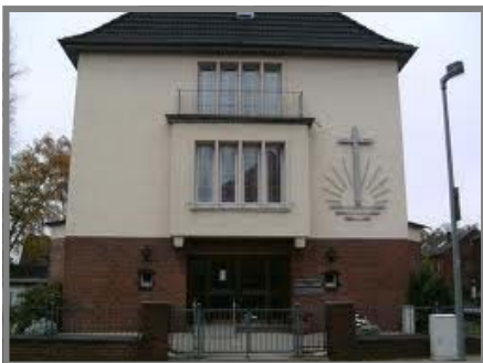
Lehmbergstraße / Ecke Wittestraße
